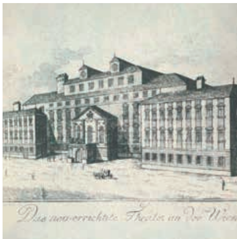
Het Theater an der Wien, vlak na de bouw in 1801
